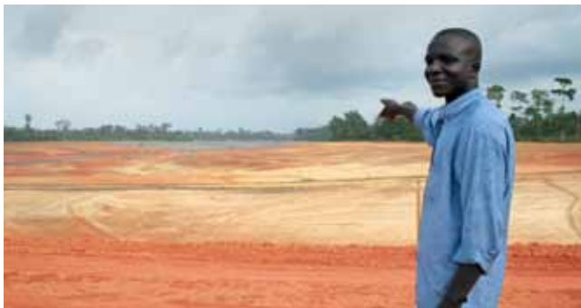
Hier soll ein riesiges Becken für Abwasser aus dem Goldabbau entstehen, Ghana 2006
