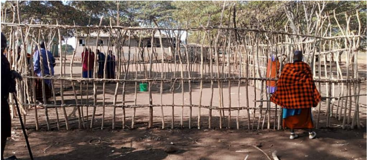
Endulen-Frauen bauen ein provisorisches Klassenzimmer
